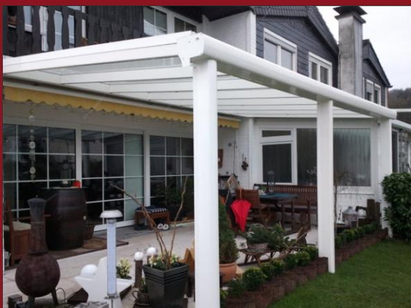
Unsere Terrassendächer werden millimetergenau aus stranggepressten und pulverbeschichteten Aluminiumprofilen hergestellt. Hierdurch garantieren wir eine nahezu pflegefreie Nutzung und die Langlebigkeit des Daches.
